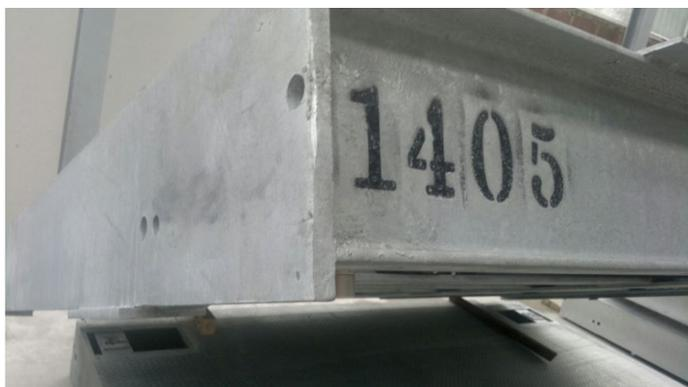
Con il trattamento di zincatura, nelle fasi di preparazione, la struttura viene sottoposta a operazioni di sgrassaggio e decapaggio, che servono a rimuovere le eventuali impurità o i residui di ruggine, in modo che il rivestimento in zinco possa aderire in maniera ideale alle superfici.
