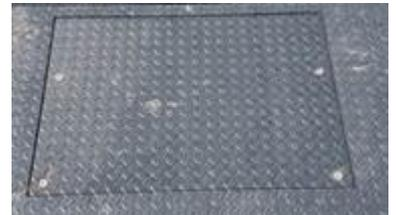
Direttamente alle celle di carico per effettuare la pulizia per la manutenzione ordinaria o la sostituzione in caso di guasto. Nelle pese di ultima generazione
